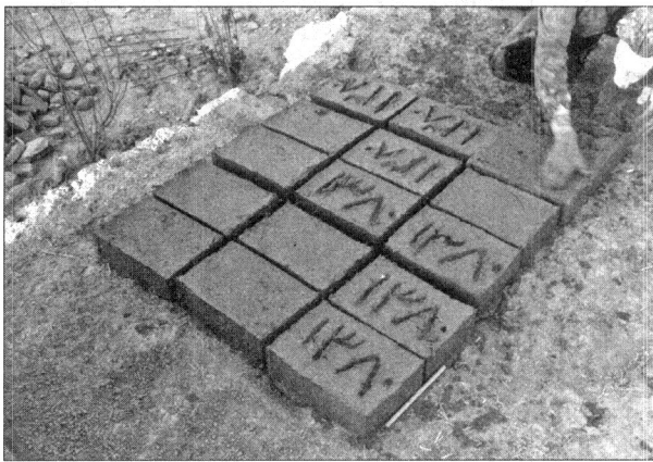
تصویر شماره ۱۴: خشت و خشت مالی، بر روی این خشتهها تاریخ مرمت دیوار (۱۳۸۰) حک شده.
