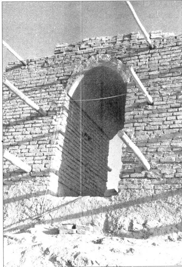
تصویر ۱۹: ورودی شمال به جنوب دیوار در دست مرمت
